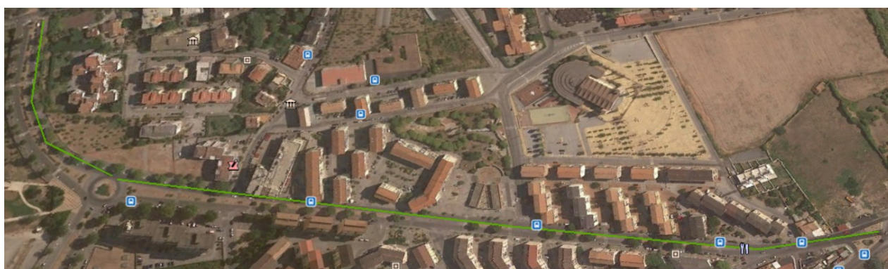
Fig. 3.82 Zona interessata dall'intervento
