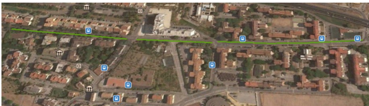
Fig. 3.81 Zona interessata dall'intervento
