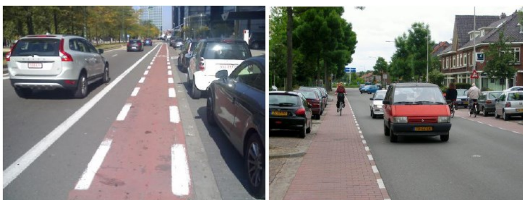
Fig. 0.5 Pista ciclabile su corsia riservata con distanza di sicurezza da automobili parcheggiate e in movimento
