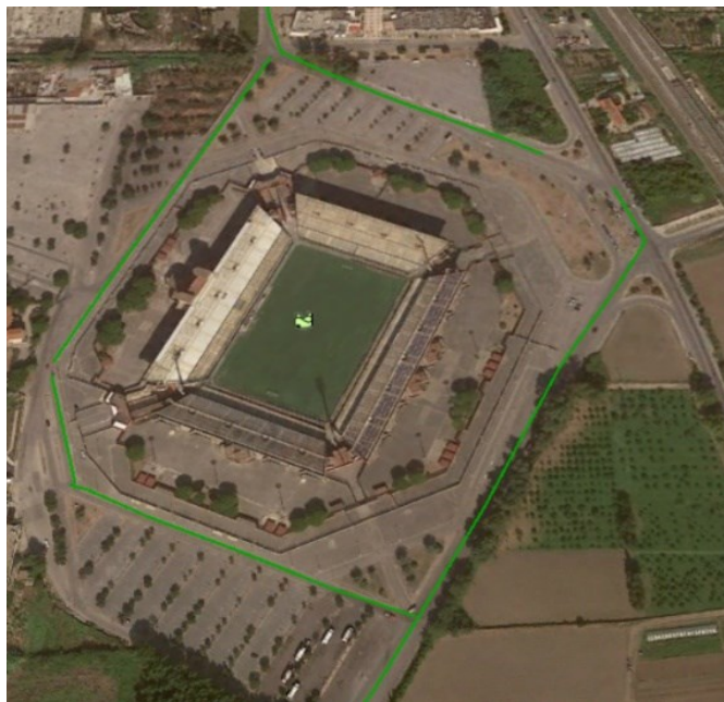
Fig. 3.72 Zona interessata dall'intervento
