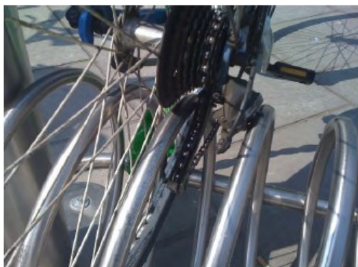
Fig. 0.18 Esempio di sostegno inadeguate
