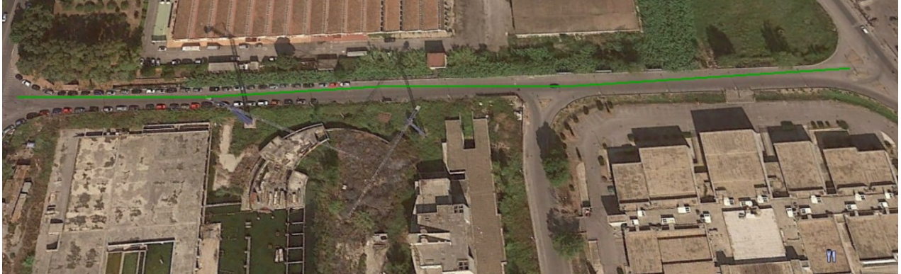
Fig. 3.74 Zona interessata dall'intervento
