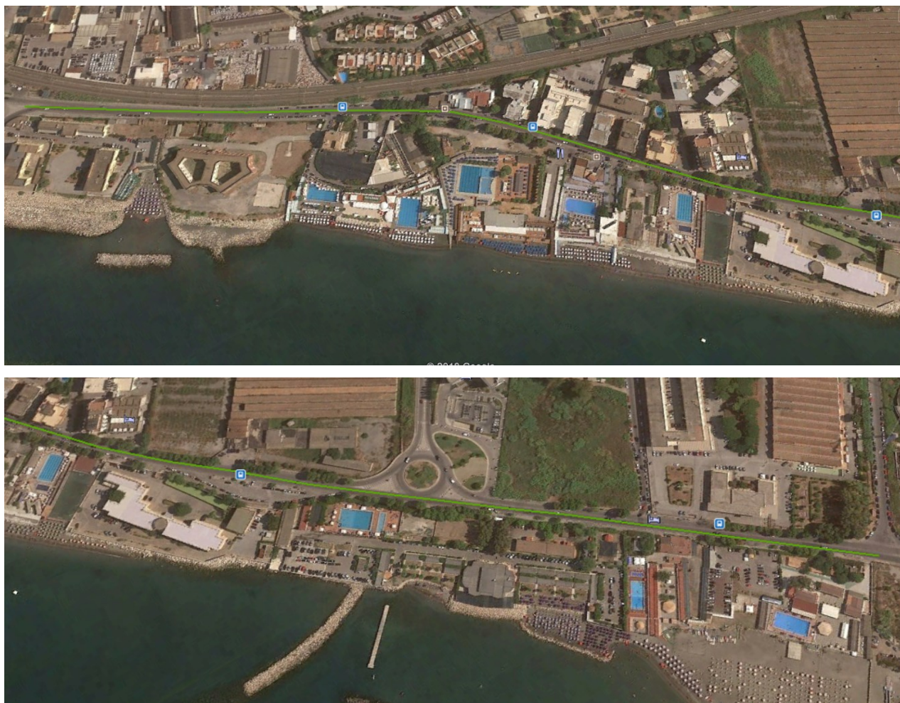
Fig. 3.68 Zona interessata dall'intervento
