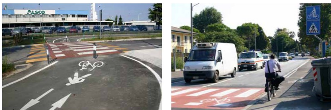
Fig. 0.10 Attraversamento ciclabile con opportuna segnaletica verticale e orizzontale
