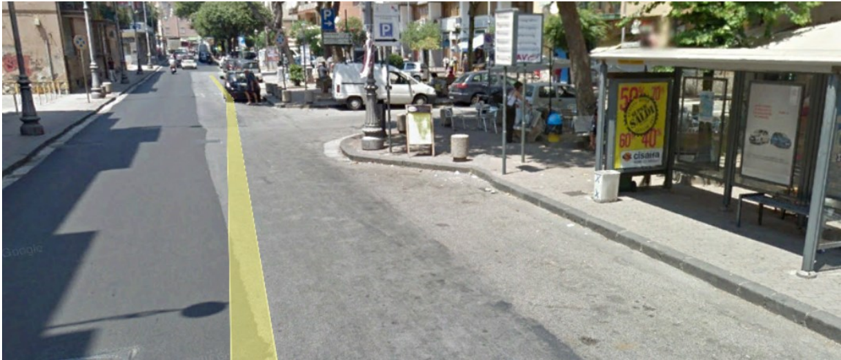
Fig. 3.27 Zona interessata dall'intervento
