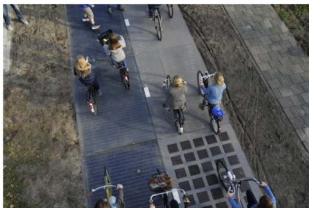
Fig. 0.41 Tratto della pista fotovoltaica in Olanda
