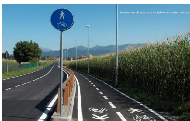
Fig. 0.6 Percorso promiscuo pedonale e ciclabile con segnaletica verticale
