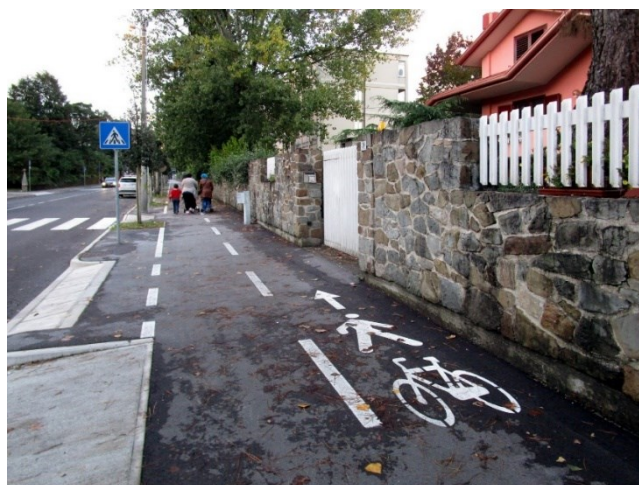
Fig. 0.7 Percorso promiscuo pedonale e ciclabile con segnaletica orizzontale
