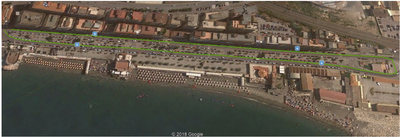
Fig. 3.67 Zona interessata dall'intervento
