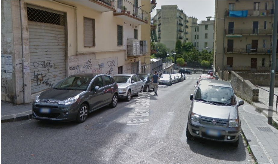
Fig. 4.63 Secondo attraversamento lungo il tratto- segnaletica quasi completamente cancellata.
