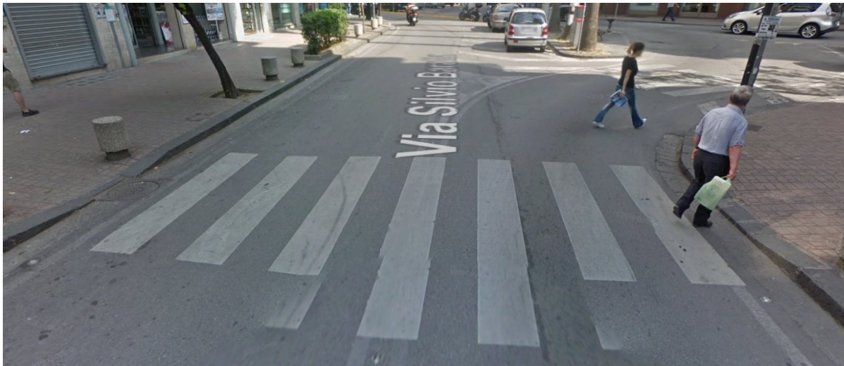
Fig. 4.31 Quarto attraversamento lungo il tratto – Inadeguatezza scivolo per presenza di tombino (da un lato) in sua corrispondenza e mancanza di contatto con l'asfalto (altro lato)
