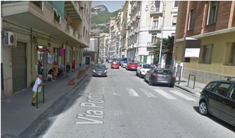
Fig. 4.50 Attraversamento 3 – Segnaletica orizzontale presente solo parzialmente
