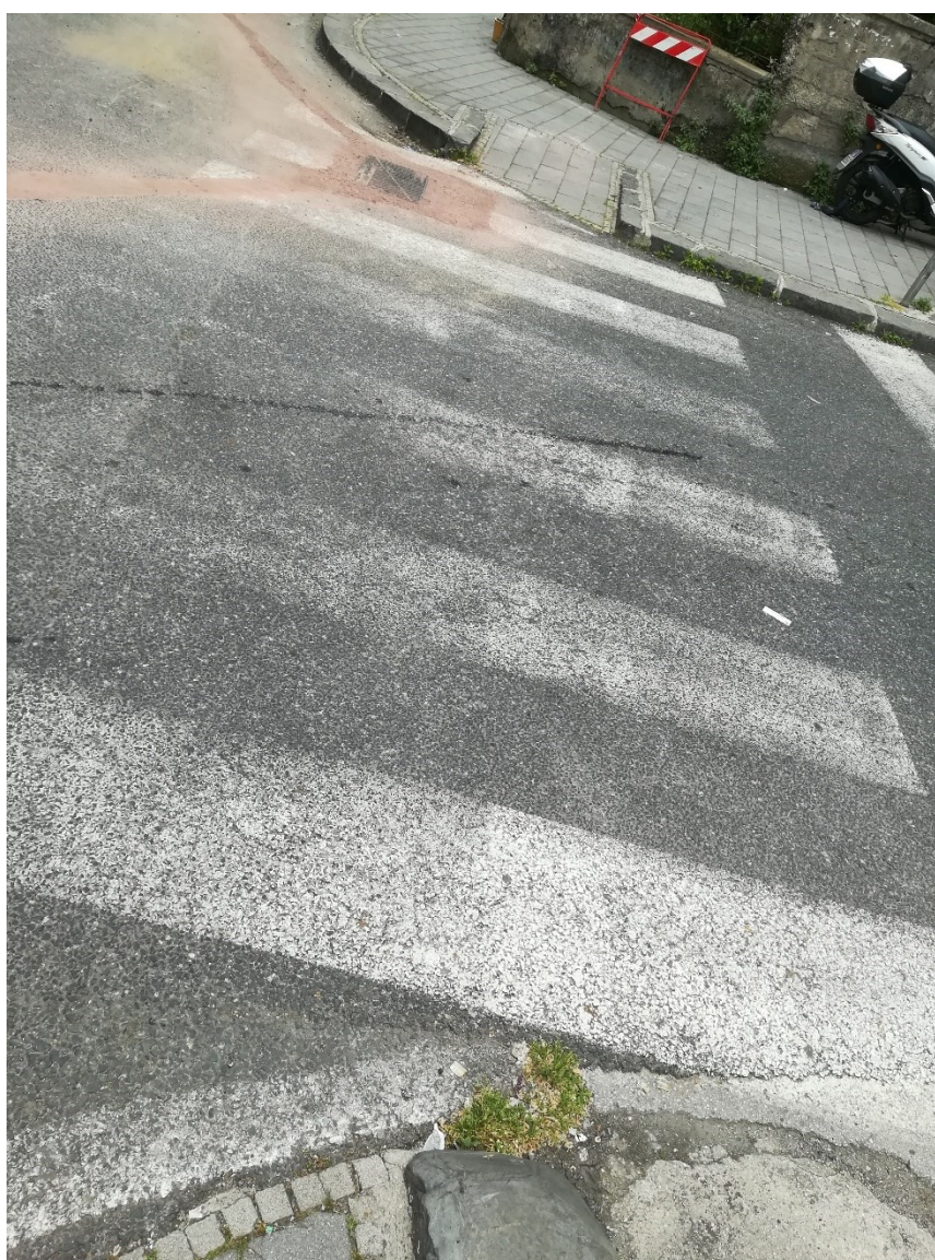
Fig. 4.64 Attraversamento lungo il tratto – segnaletica orizzontale
