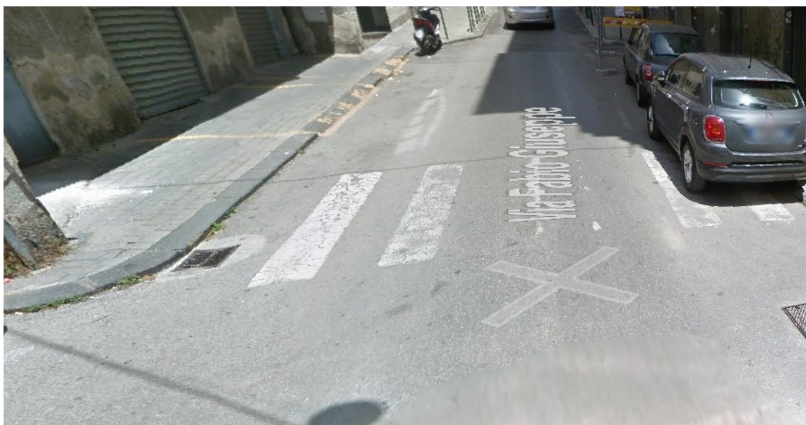
Fig. 4.70 Primo attraversamento lungo il tratto – segnaletica orizzontale
