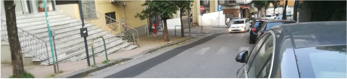
Fig. 4.91 Terzo attraversamento lungo il tratto – segnaletica orizzontale insufficiente
