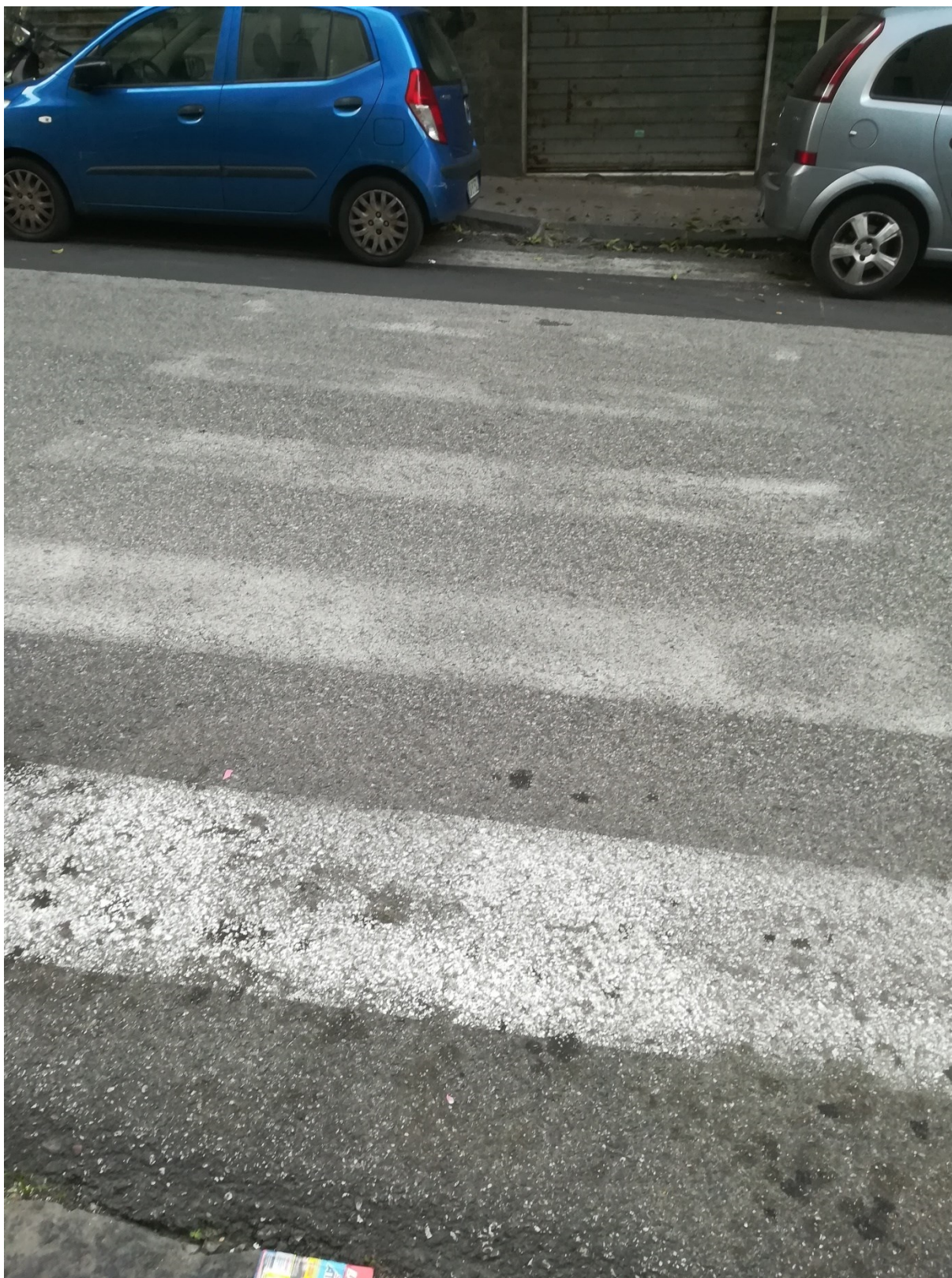
Fig. 4.93 Sesto attraversamento lungo il tratto – segnaletica orizzontale insufficiente
