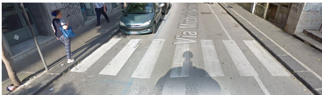
Fig. 4.57 Terzo attraversamento lungo il tratto - assenza di scivolo disabili.
