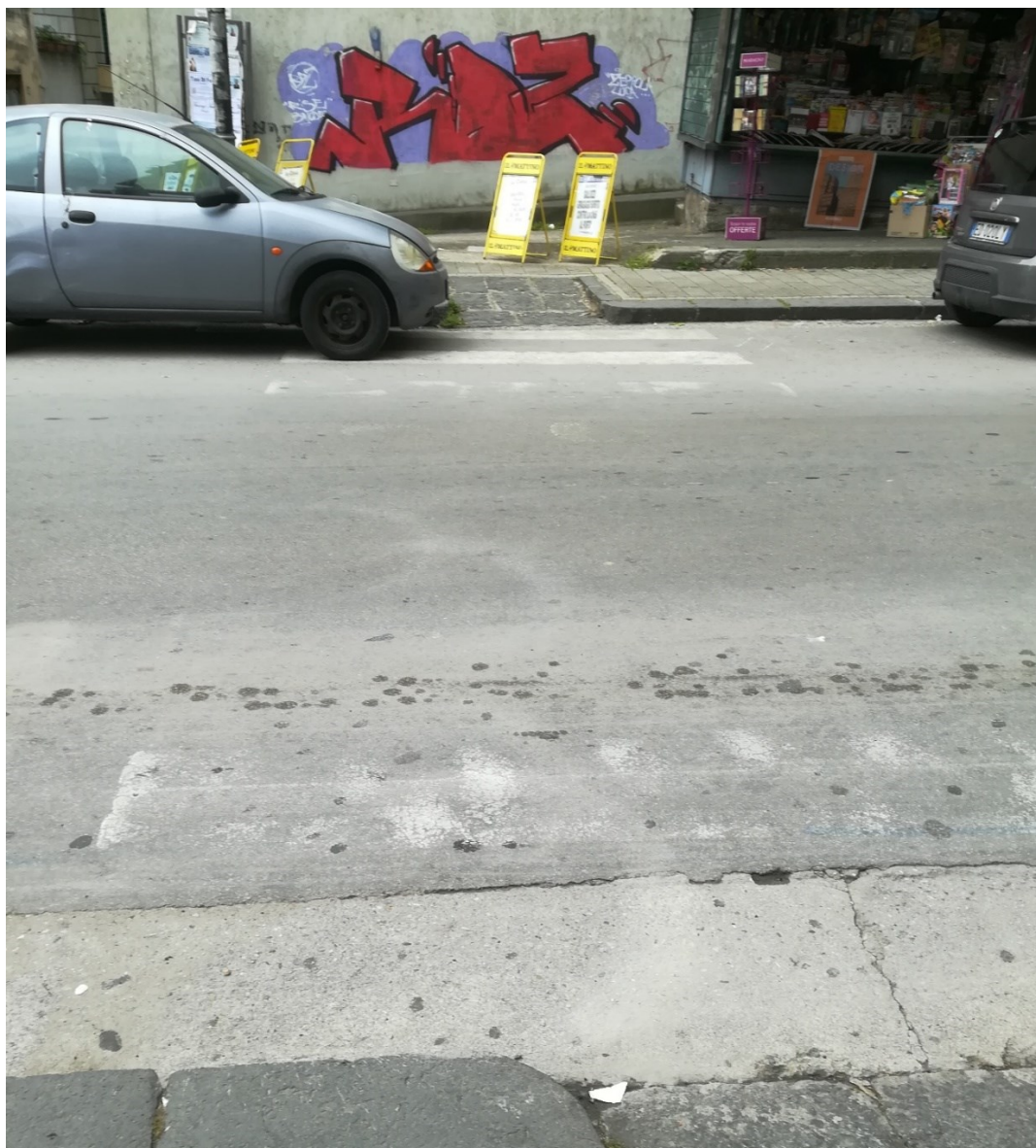
Fig. 4.12 Terzo attraversamento lungo il tratto, in corrispondenza della fermata autobus.
