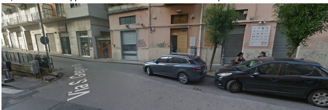
Fig. 4.115 Discontinuità del marciapiede destro all'intersezione con via San Gregorio VII
