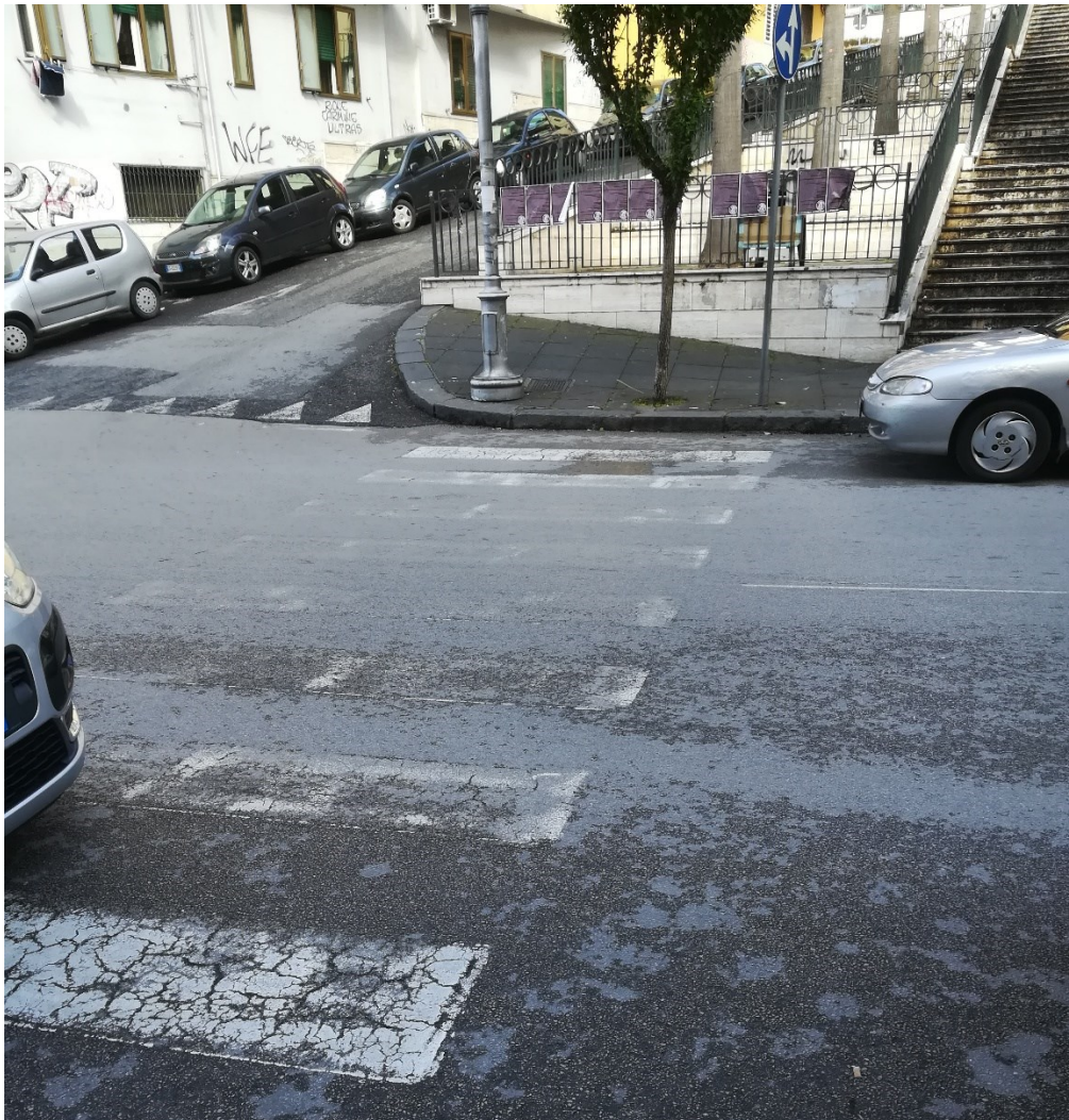
Fig. 4.3 Primo attraversamento lungo il tratto, Largo Sinno
