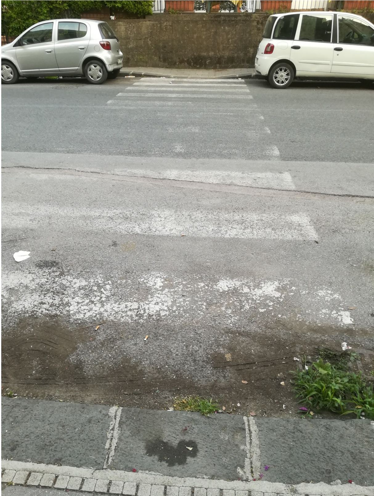
Fig. 4.100 Settimo attraversamento lungo il tratto – segnaletica orizzontale insufficiente e inadeguatezza scivoli (erbacce dove dovrebbe esserci il contatto marciapiede- asfalto)
