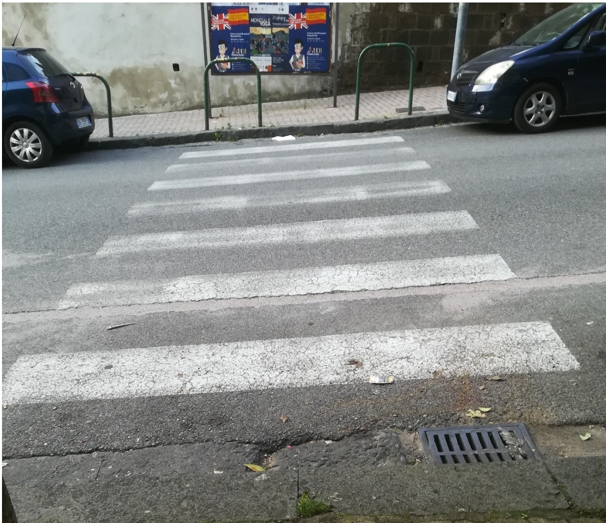
Fig. 4.90 Quarto attraversamento lungo il tratto - assenza di scivoli e segnaletica orizzontale in stato sufficiente
