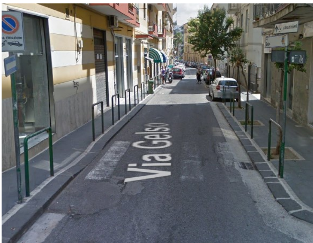
Fig. 4.1 Terzo attraversamento lungo il tratto, segnaletica orizzontale poco visibile
