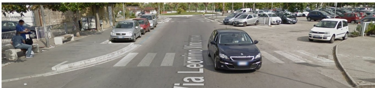
Fig. 4.36 Quarto attraversamento lungo il tratto -assenza di rampe
