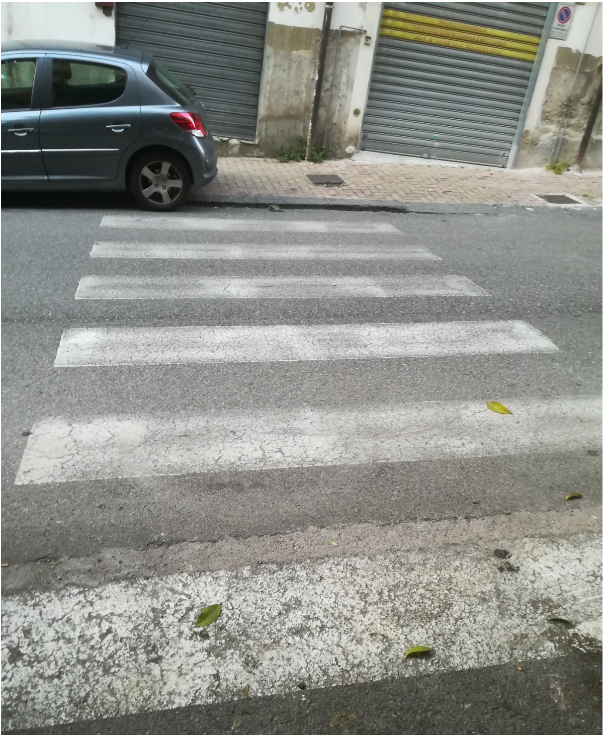
Fig. 4.92 Quinto attraversamento lungo il tratto – assenza di scivoli e segnaletica orizzontale in stato sufficiente
