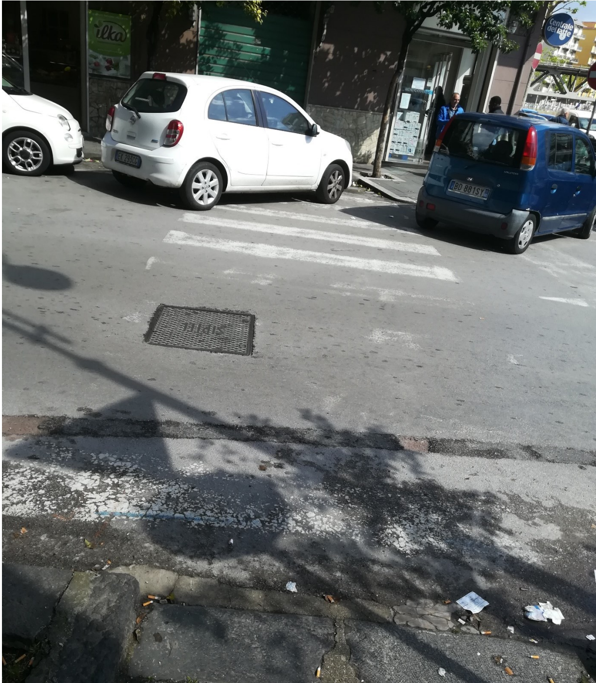
Fig. 4.20 Quarto attraversamento sulla destra, intersezione con via Nizza- ripristino della segnaletica orizzontale necessario. L'assenza degli scivoli è in qualche modo giustificata dall'inutilizzo da parte di persone diversamente abili del marciapiede di sinistra, a causa delle dimensioni ridotte; Tuttavia, data l'impossibilità di utilizzare entrambi i marciapiedi sarebbe necessario prevedere, in corrispondenza dello stallo per disabili, un attraversamento pedonale, che consenta immediatamente il raggiungimento del marciapiede opposto, nonostante la ridotta distanza dall'attraversamento successivo.
