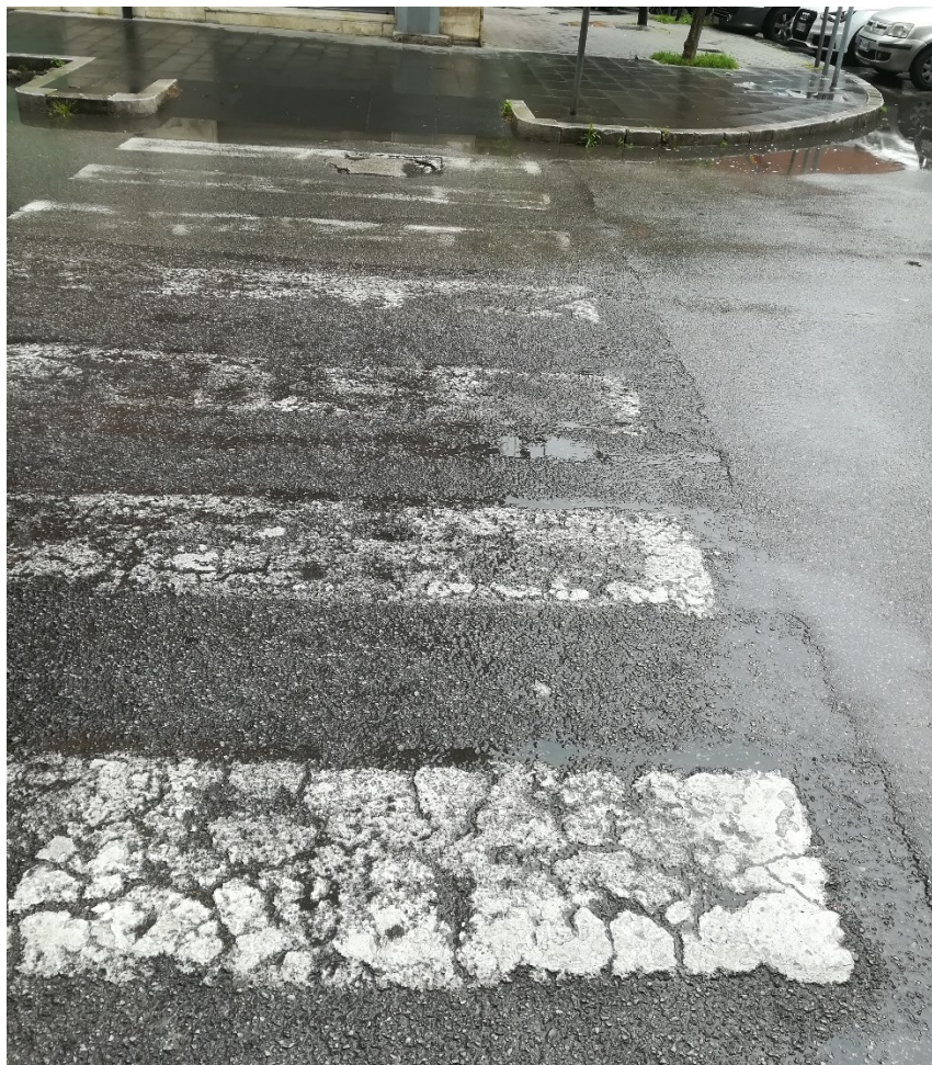
Fig. 4.18 Terzo attraversamento lungo il tratto
