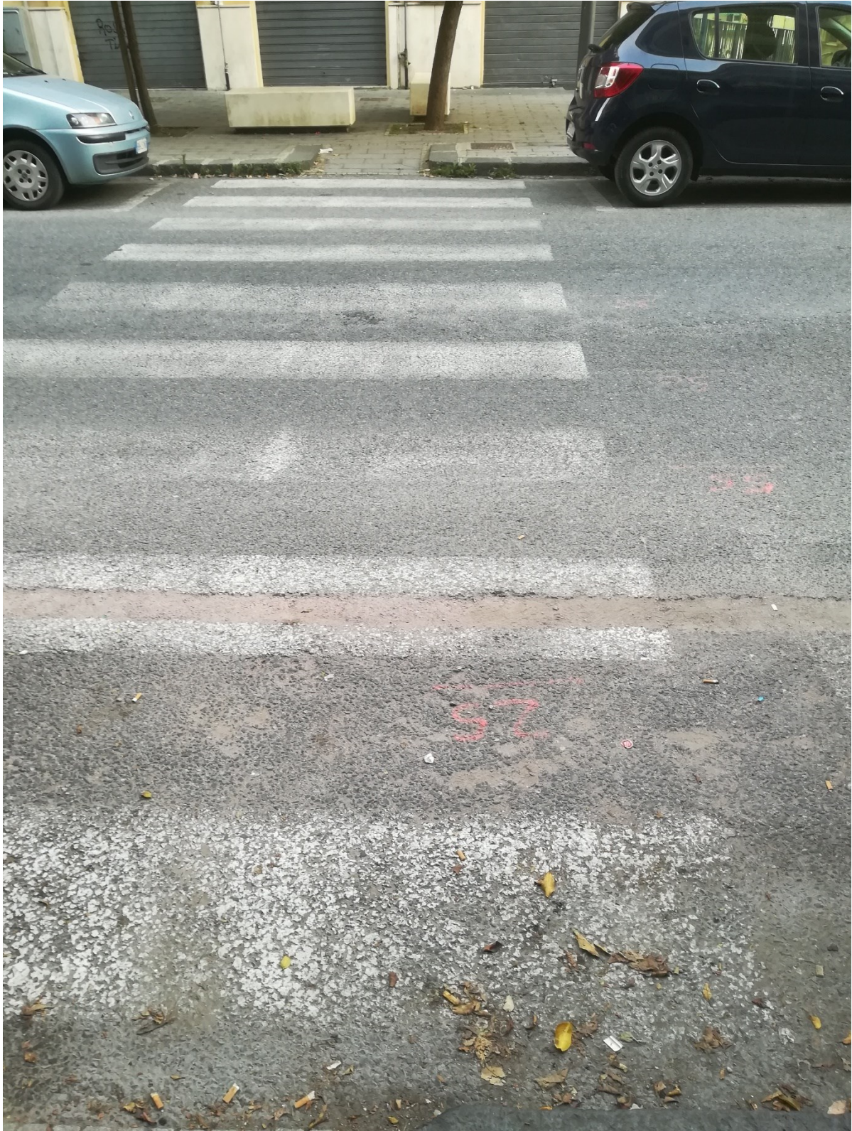
Fig. 4.99 Quinto attraversamento lungo il tratto – segnaletica in stato sufficiente
