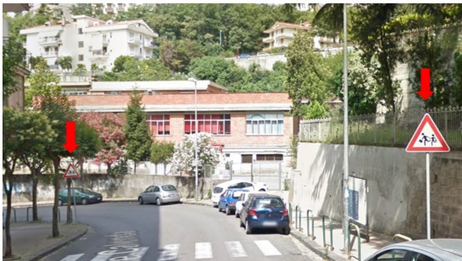
Fig. 4.88 Quarto attraversamento lungo il tratto - Riposizionamento del cartello in basso necessario
