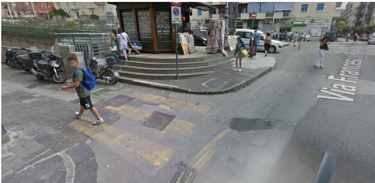
Fig. 4.75 Attraversamento sulla sinistra, all'intersezione con via Ripa- assenza di scivolo
