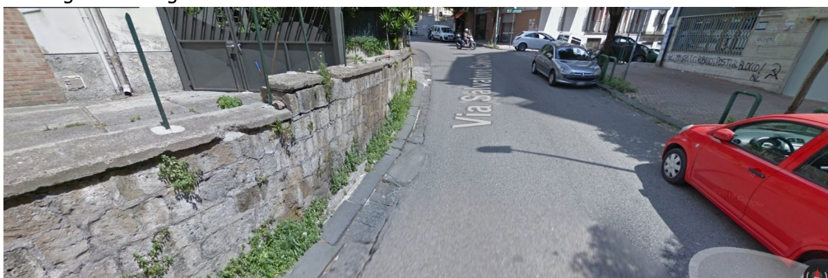
Fig. 4.94 discontinuità del marciapiede sinistro
