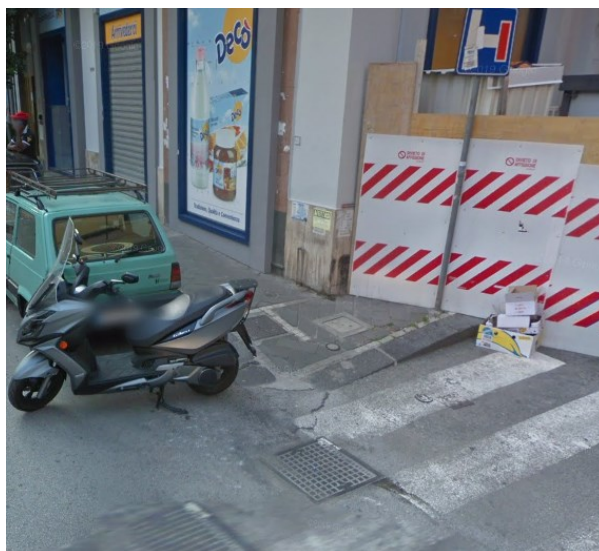
Fig. 4.55 Scivolo del primo attraversamento sulla sinistra
