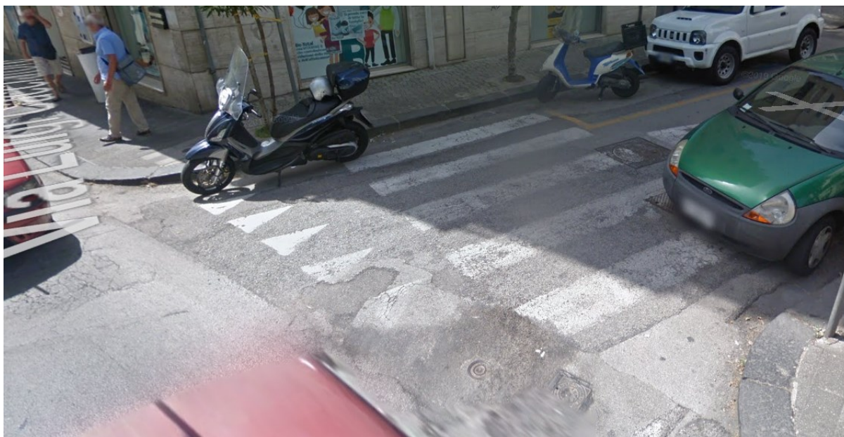
Fig. 4.15 Primo attraversamento sulla destra, assenza dello scivolo disabili
