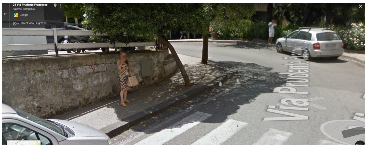
Fig. 4.81 Assenza di scivolo ed interruzione del marciapiede.
