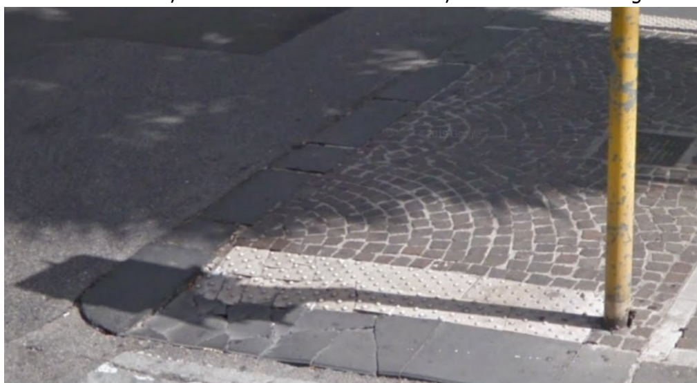
Fig. 4.9 Dettaglio dello scivolo del secondo attraversamento a sinistra, intersezione con la corsia di Garibaldi dedicata al trasporto privato.
