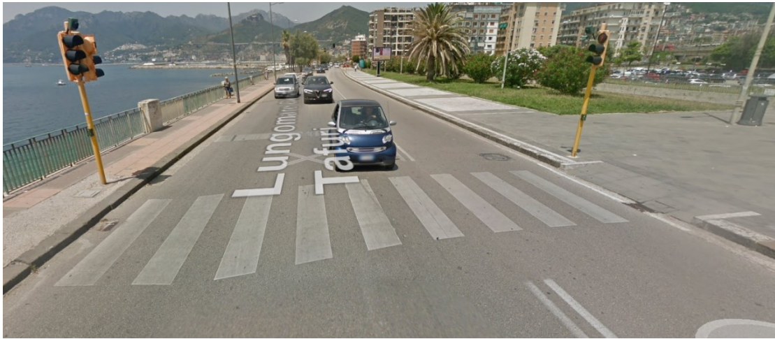
Fig. 4.47 Attraversamento 1 lungo il tratto - Scivolo presente solo da un lato
