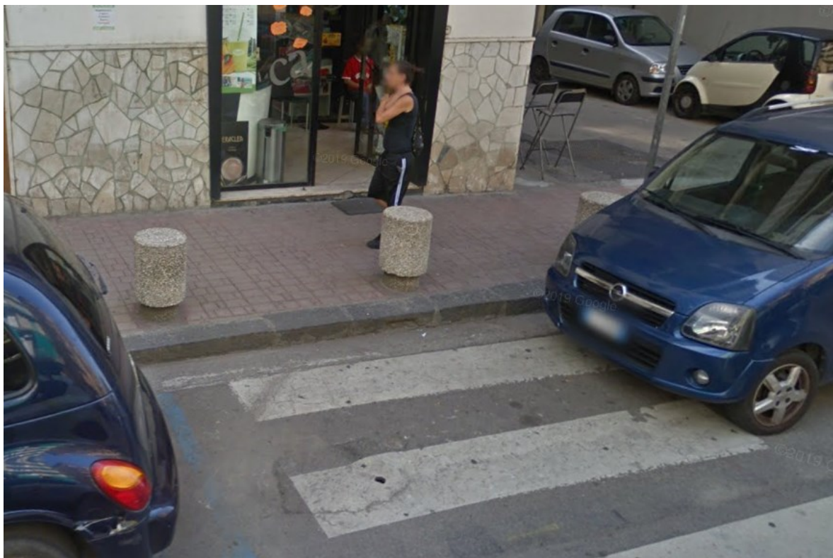
Fig. 4.32 Quinto attraversamento lungo il tratto – Assenza scivolo disabili
