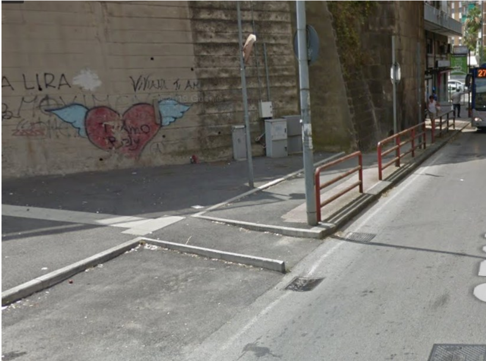
Fig. 4.29 Collegamento non adeguato con il marciapiede adiacente
