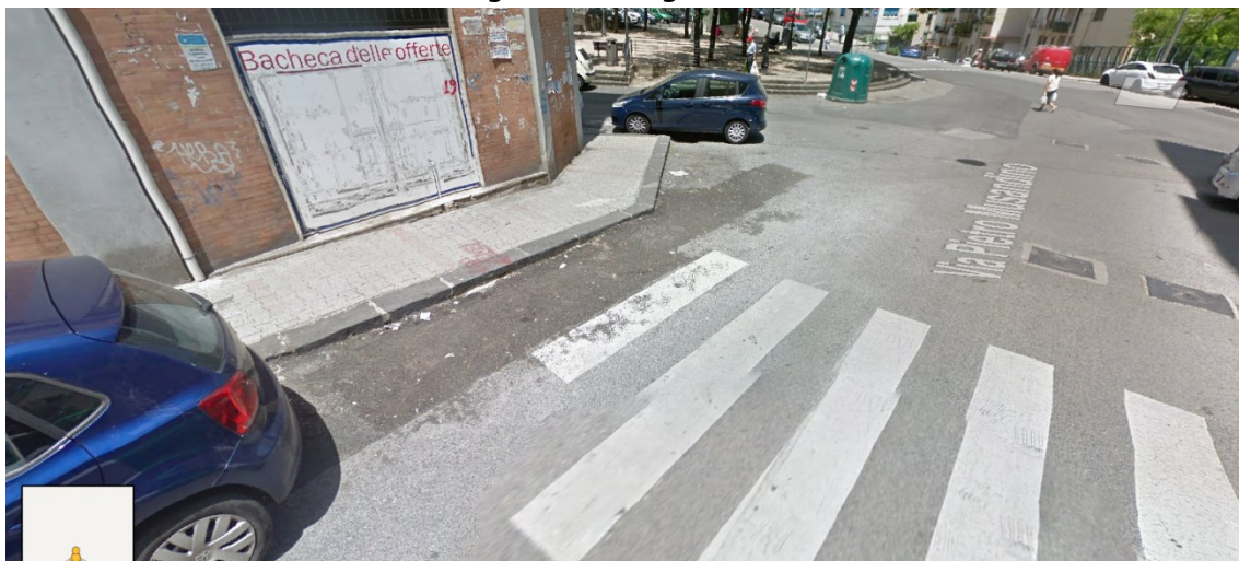
Fig. 4.68 Attraversamento lungo il tratto- scivolo assente
