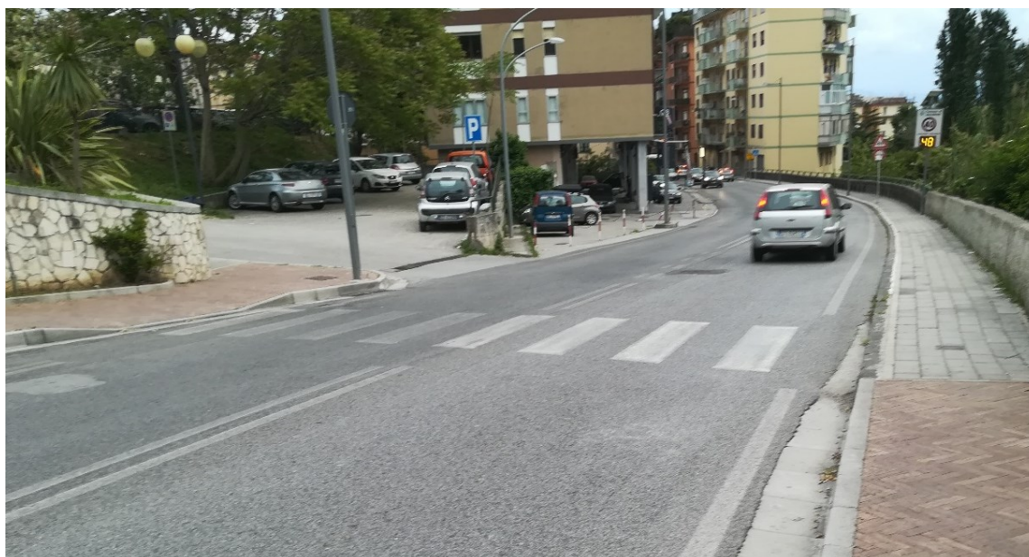
Fig. 4.11 Secondo attraversamento lungo il tratto, assenza di segnaletica verticale e segnaletica orizzontale appena sufficiente (quasi cancellata sul lato sinistro).
