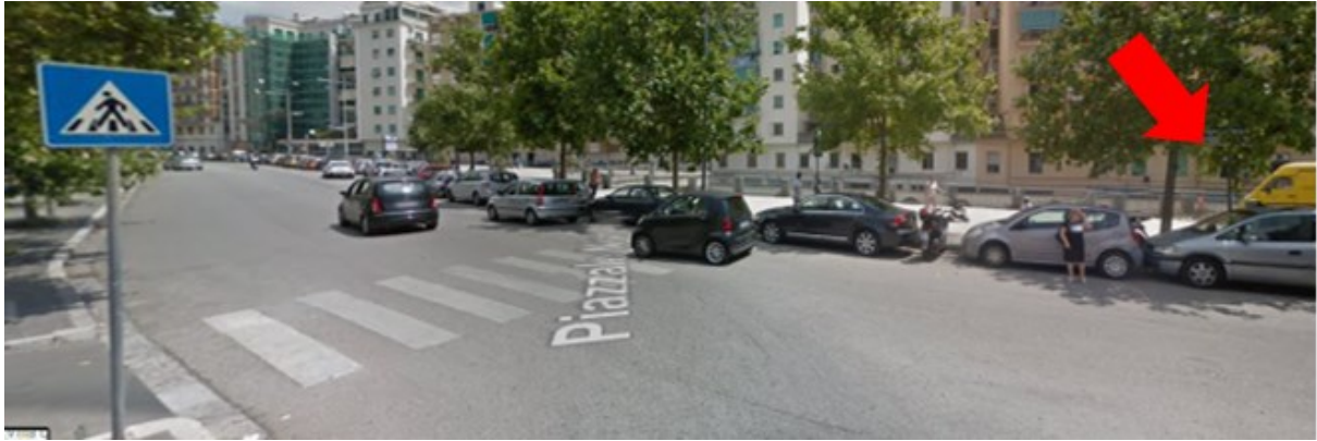
Fig. 4.16 Primo attraversamento sulla sinistra, segnaletica verticale coperta dall'albero e qualità della segnaletica orizzontale appena sufficiente.
