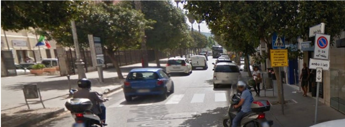
Fig. 4.48 Secondo attraversamento lungo il tratto – segnaletica verticale parzialmente coperta.
