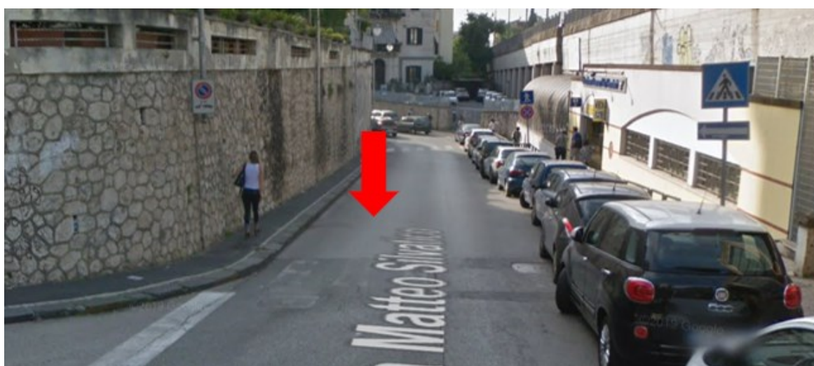
Fig. 4.60 Secondo attraversamento lungo il tratto – segnaletica orizzontale completamente cancellata
