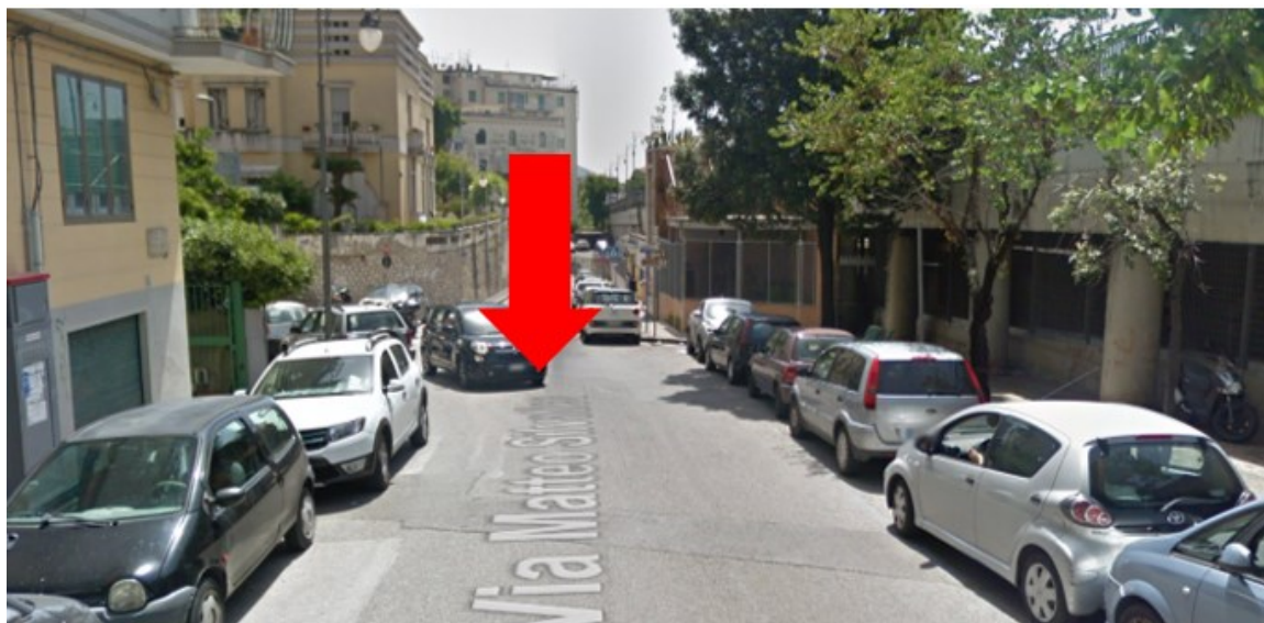
Fig. 4.61 Terzo attraversamento lungo il tratto – segnaletica orizzontale completamente cancellata
