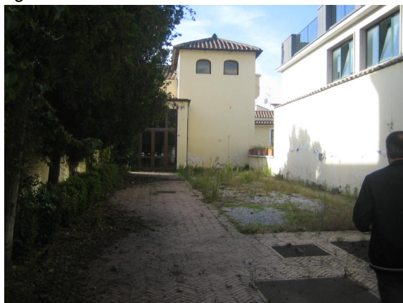
Cortile interno lato via Bastioni
