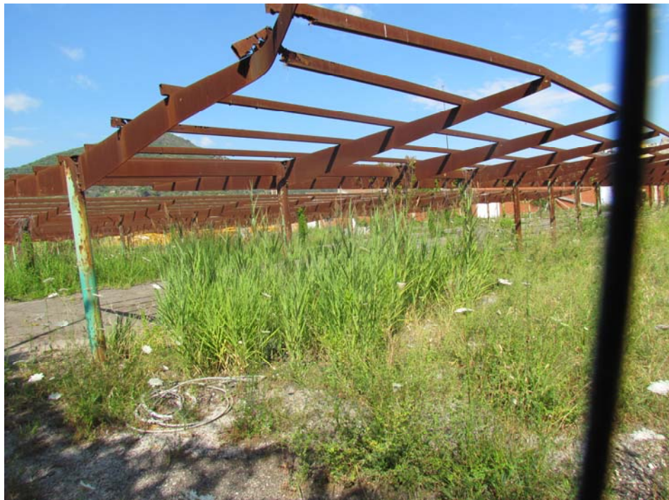
Fig.8. l'area dei parcheggi all'esterno dell'opificio
