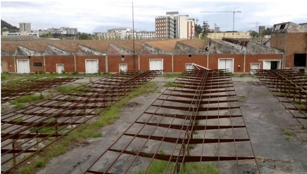
Vista del prospetto "interno" del capannone e parte degli uffici
