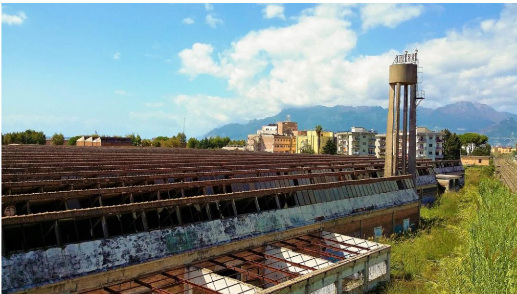
Fotografia dal cavalcavia e vista della copertura a SHED del capannone e torre dell'acqua
