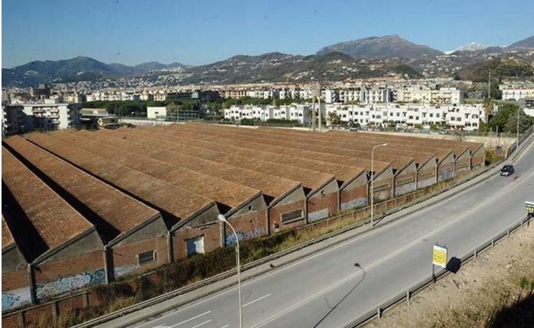
Fotografia dall'alto che inquadra il capannone e la sua caratteristica copertura a SHED
