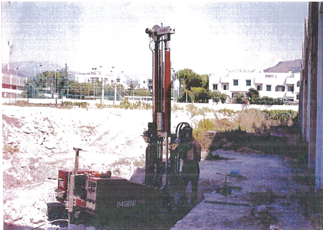
Prova Penetrometrica Statica P2
