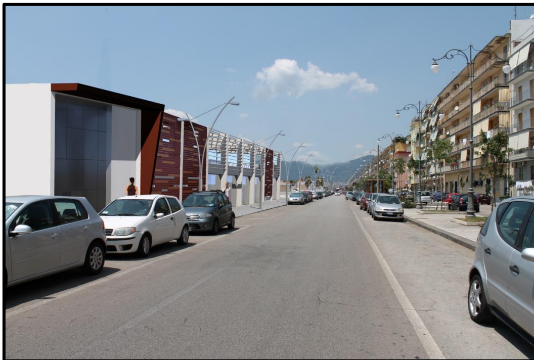
Ingresso principale del Corpo B lungo via Leucosia
