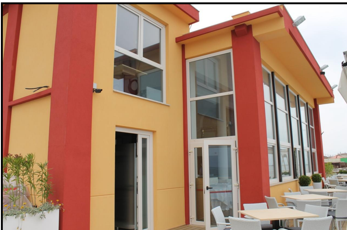
Vista del fronte prospiciente il mare.
