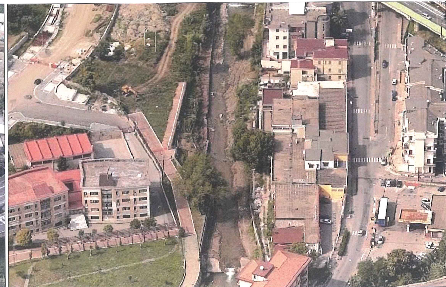
L'area di intervento verso Nord
