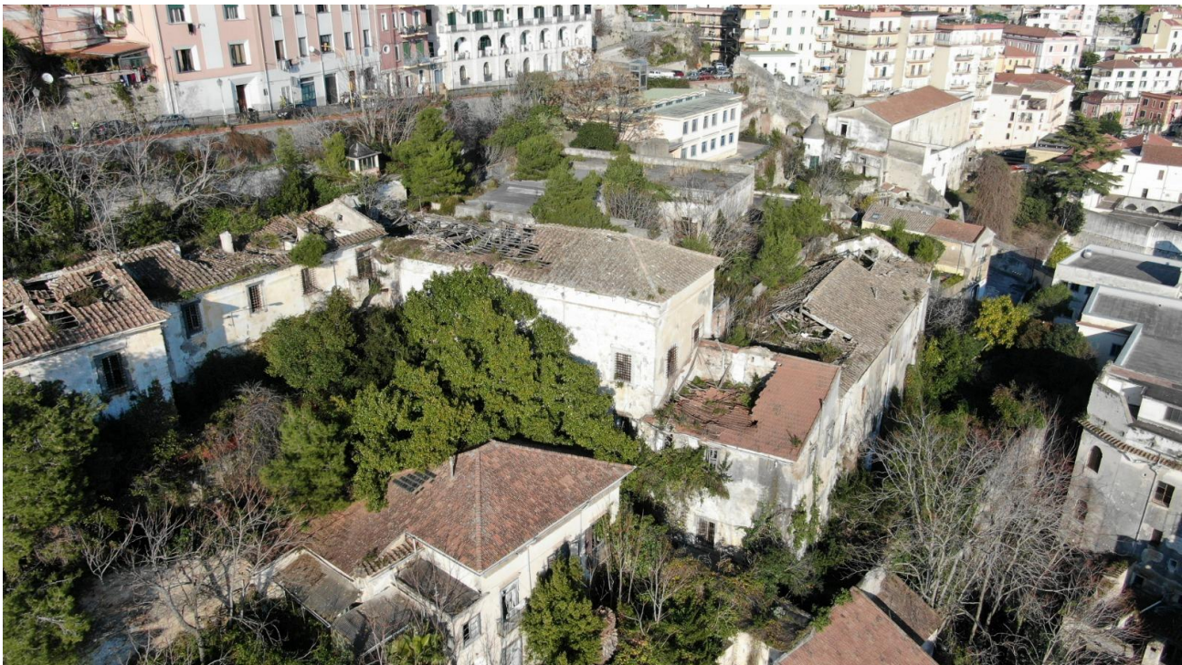
Foto: Convento di San Francesco, evidente la condizione di degrado e scarsa sicurezza della struttura, nel pieno centro storico di Salerno; inquadratura da drone - volo effettuato in data 27 gennaio 2021 dal gruppo di lavoro dell'Università Telematica Pegaso
