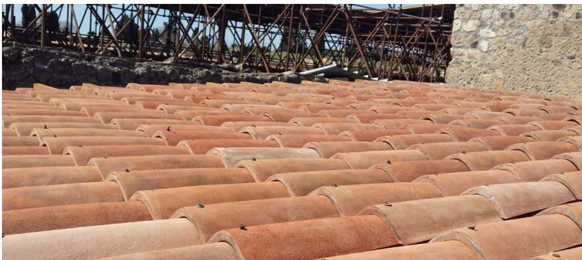
Figura 6 - Dettaglio di come si presentano le tegole fotovoltaiche una volta installate
