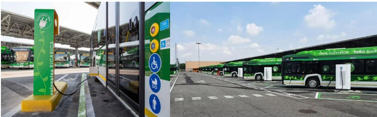
**Figura 36-** Infrastruttura di ricarica in deposito
