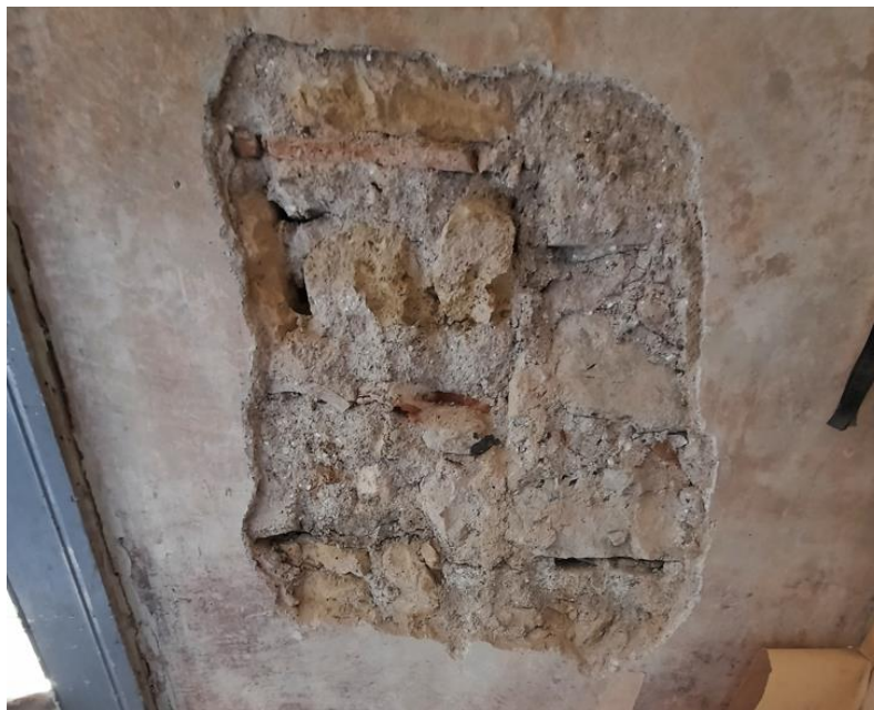
Foto n. 1 – Saggio su muratura n. 1 Muratura in pietrame di tufo sbazzato listata con mattoni pieni
