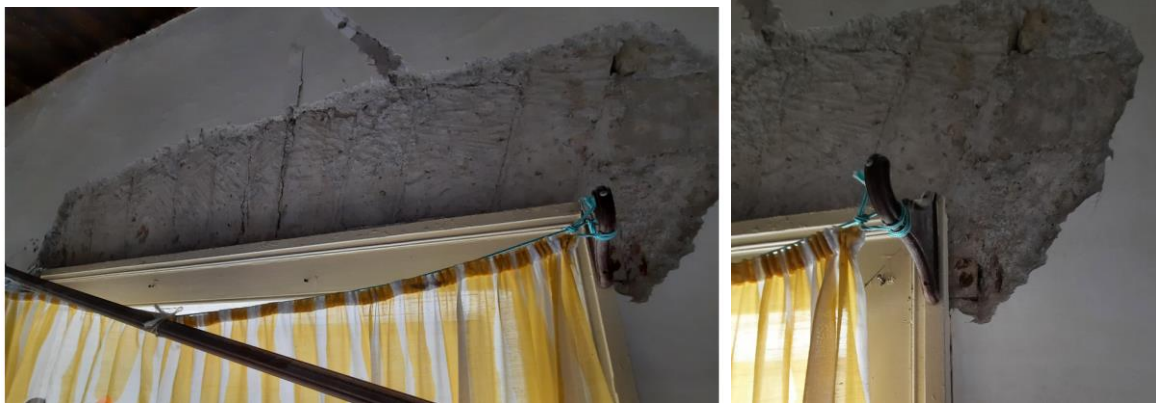
FOTO 21: Architrave in muratura
