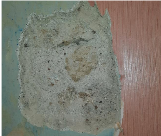
Foto n. 2: Saggio su muratura n. 2: Muratura in pietrame di tufo sbizzato
