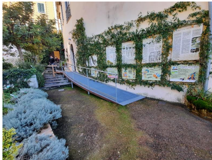
Figura 12: Rampa di accesso al primo terrazzamento
