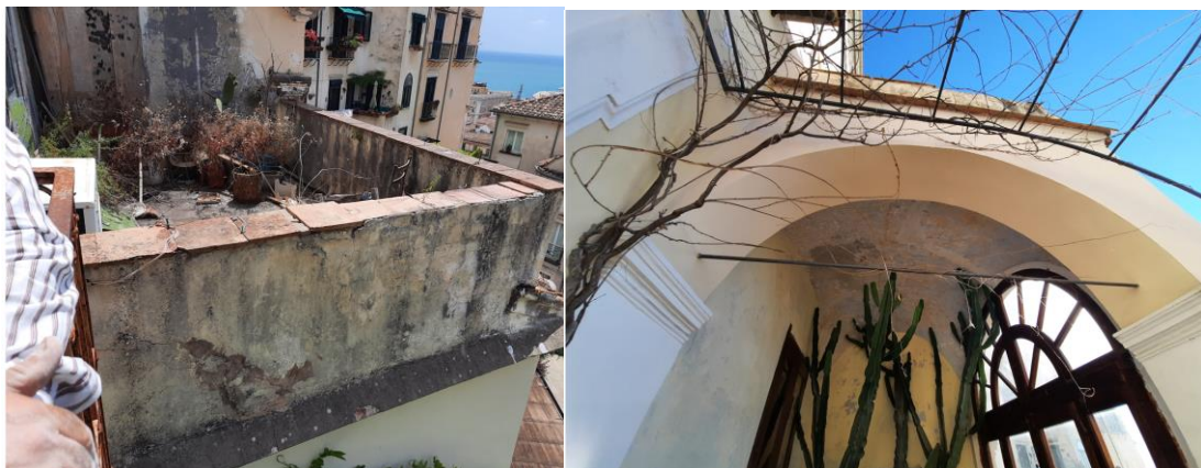
FOTO 22: Vista del terrazzino e della volta che lo sostiene
