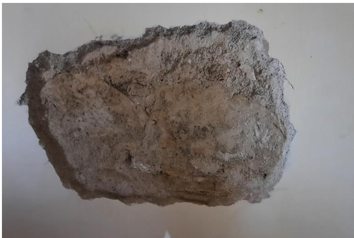
FOTO 19: Saggio su muratura n. 3: Muratura in pietrame di tufo sbizzato
