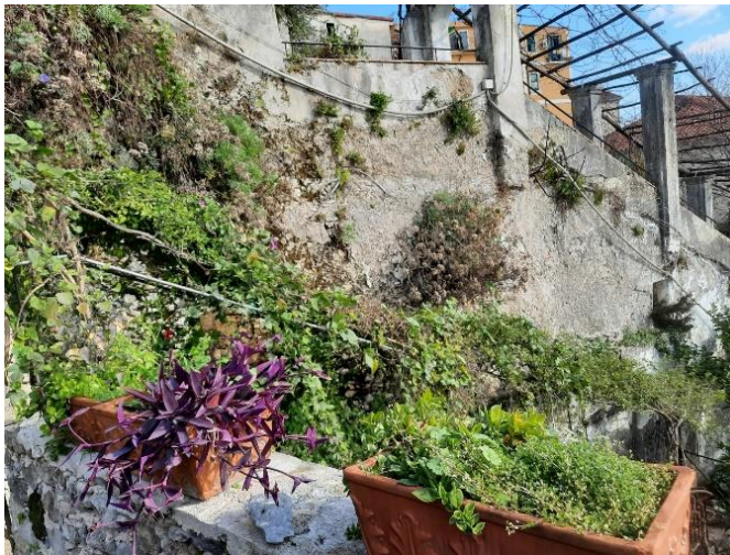
FOTO 15-FOTO 16: Murazione di confine con la proprietà Pagano, è evidente il crollo dovuto alla crescita di specie invasive
