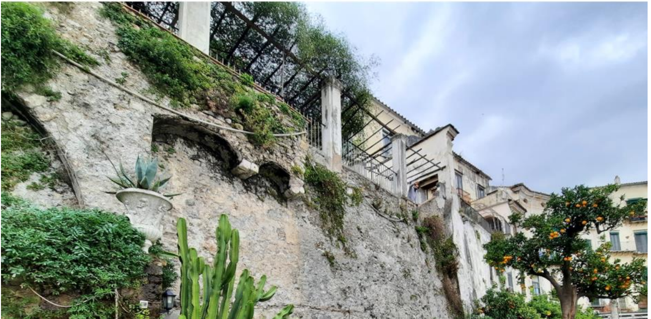
FOTO 9: Muro di contenimento del I terrazzamento del Giardino
