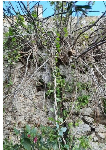
FOTO 15-FOTO 16: Murazione di confine con la proprietà Pagano, è evidente il crollo dovuto alla crescita di specie invasive
