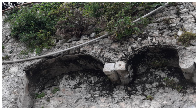
FOTO 10: arco in conci tufacei con tracce di intonaco dipinto
