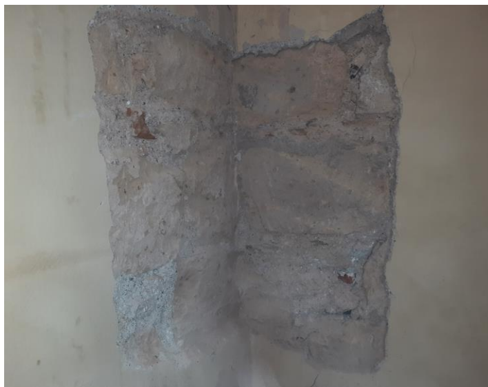
FOTO 20: Saggio su muratura n. 4: il saggio evidenzia la buona ammorsatura tra le pareti ortogonali in corrispondenza del cantonale
