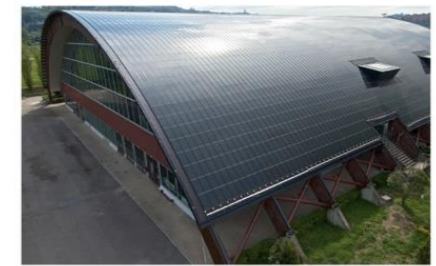
A- COPERTURA OPACA – LAMIERA SAGOMATA TIPO RIVERCLACK
