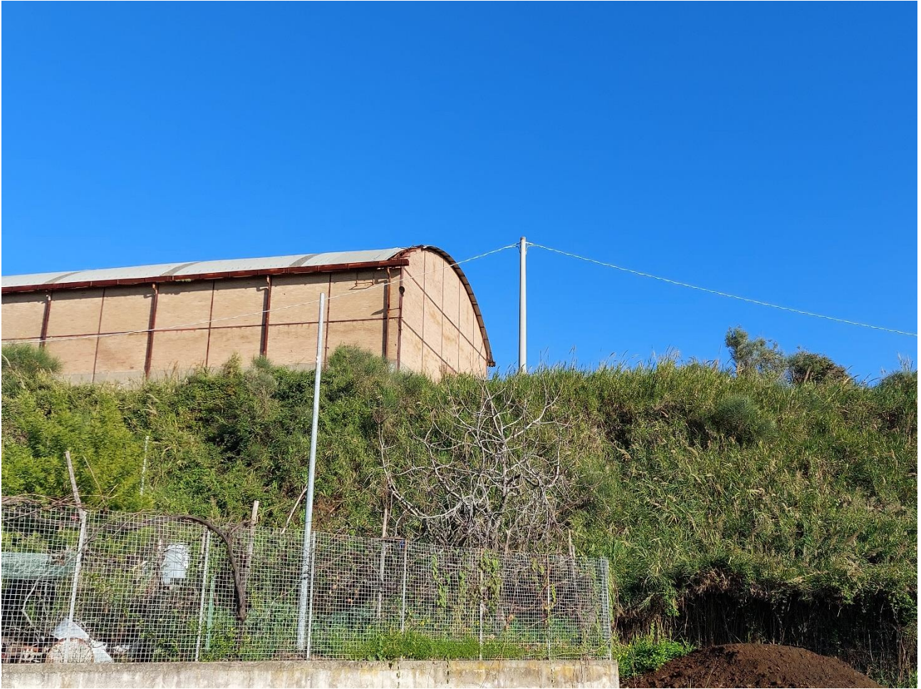
Foto 2: Partenza linea aerea in cavo su pali per alimentazione case coloniche presenti a confine dell’area interessata dall’intervento
