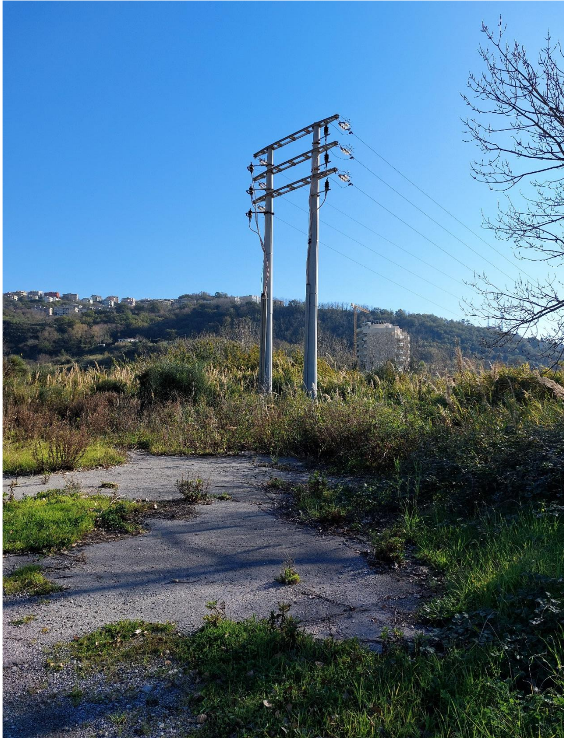
Foto n° 1: Partenza linea aerea MT in prossimità del parcheggio via Brignano
