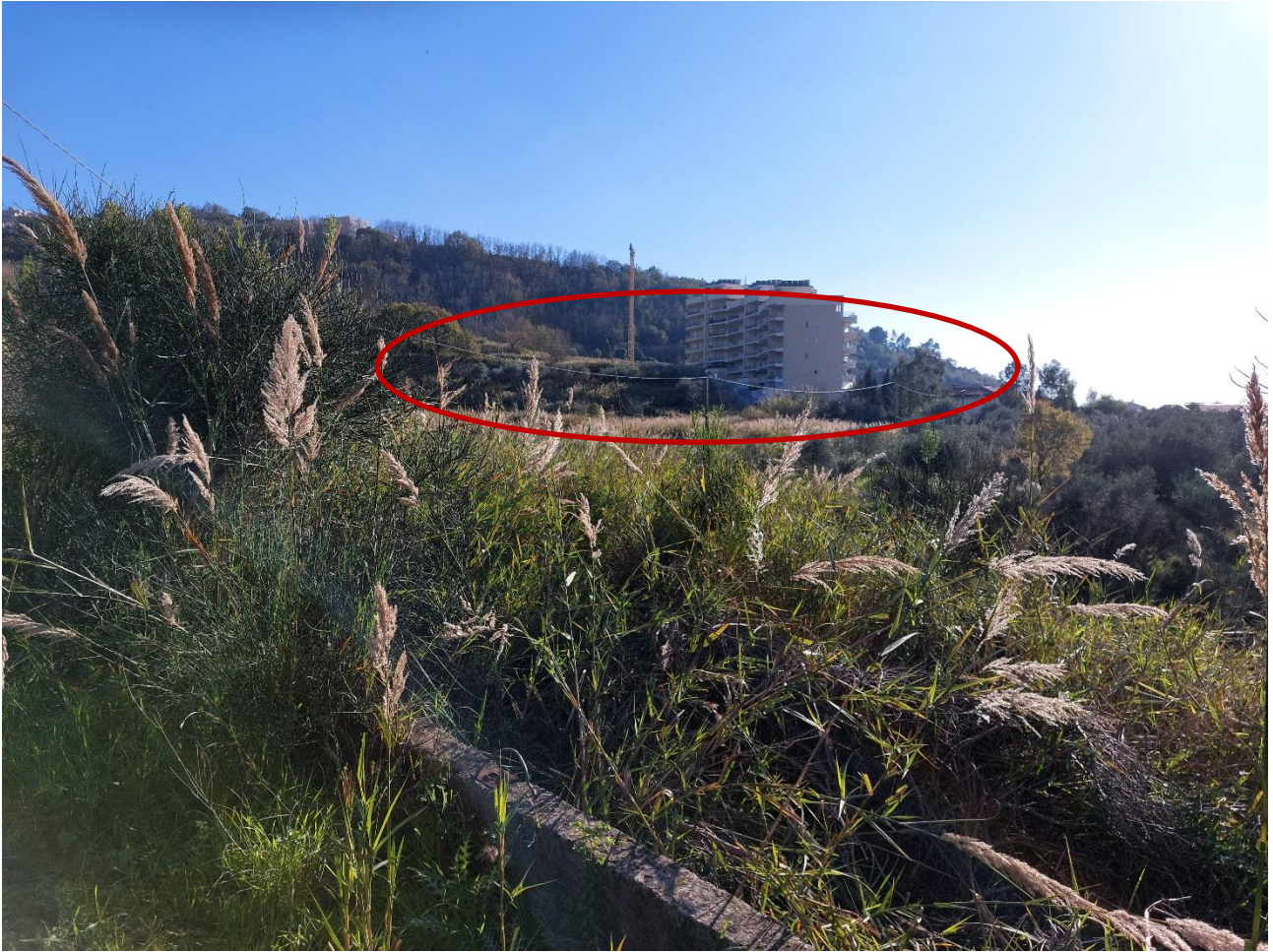
Foto 4 : Attestazione linea aerea in cavo per alimentazione case coloniche presenti a confine dell’area interessata dall’intervento
