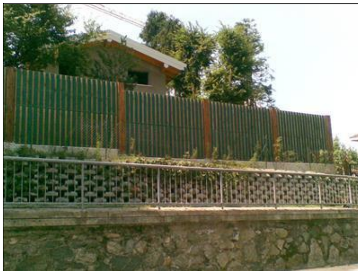
Figura 4 – Barriere artificiali con pannellatura in legno
