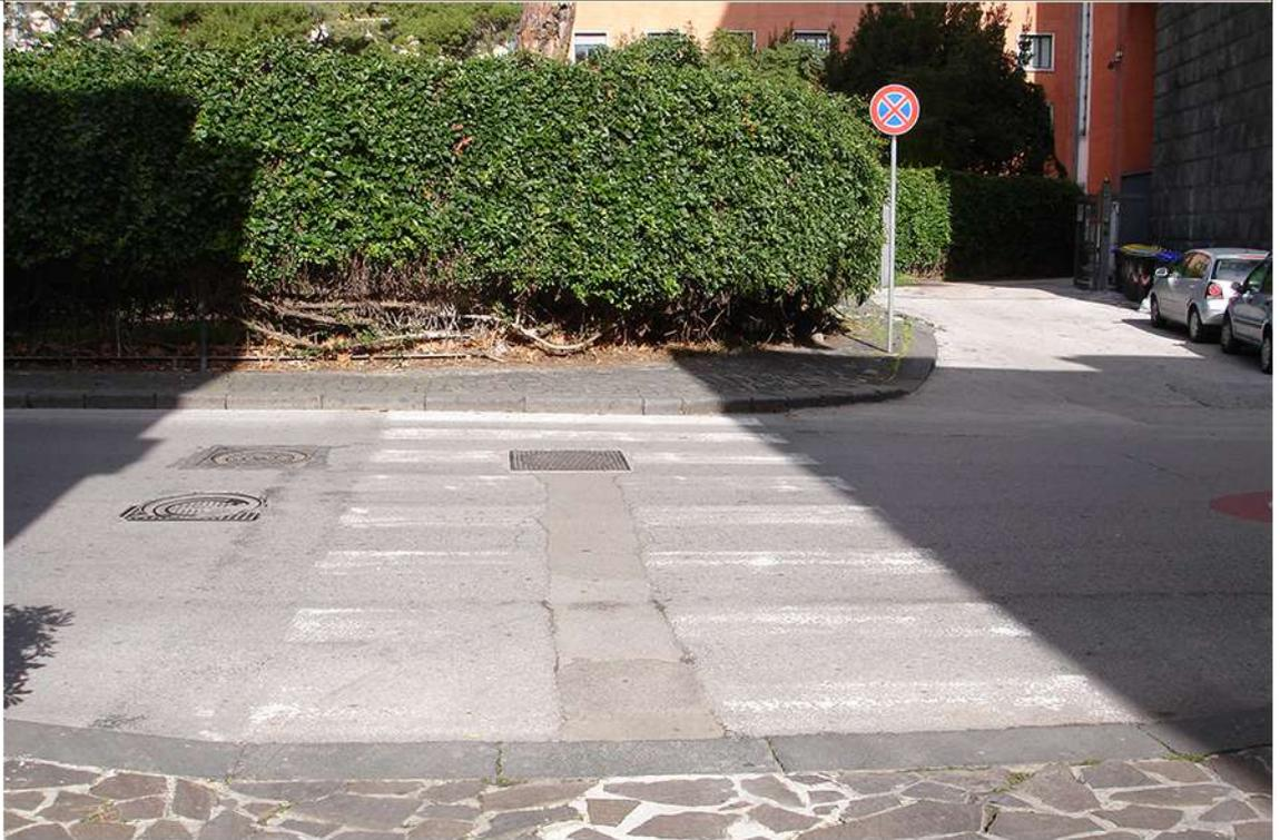
**dislivello causato da gradino di altezza complessiva 2,5/30cm**
