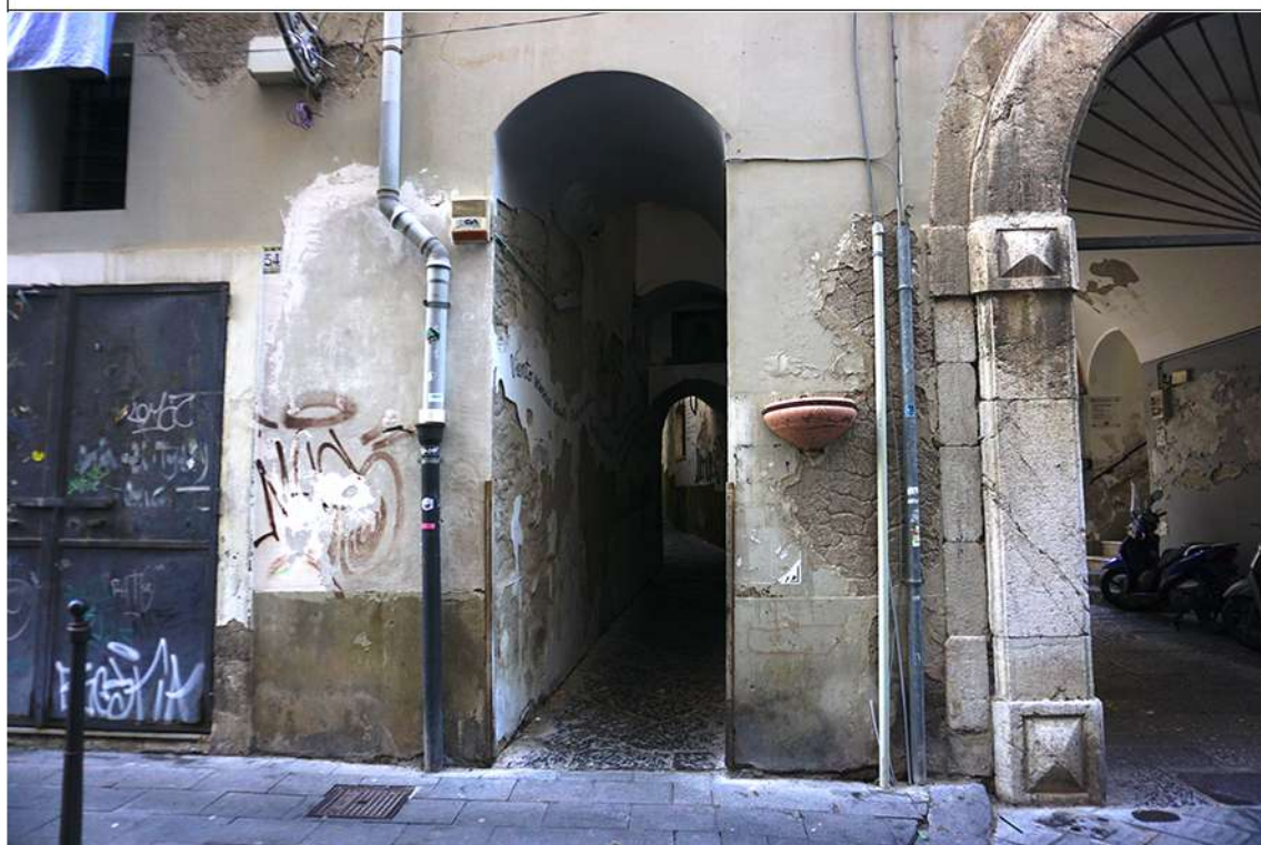
Ostacoli su percorso pedonale (fioriera a parete)
