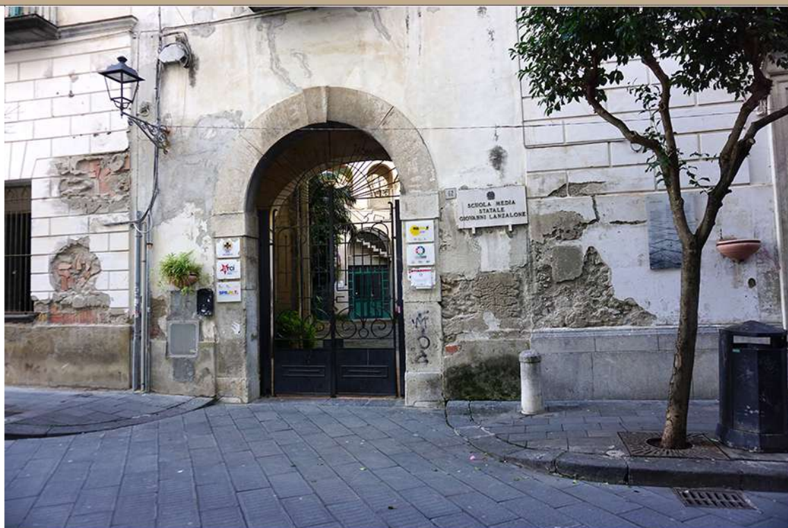
Ostacoli su percorso pedonale (dissuasore)
