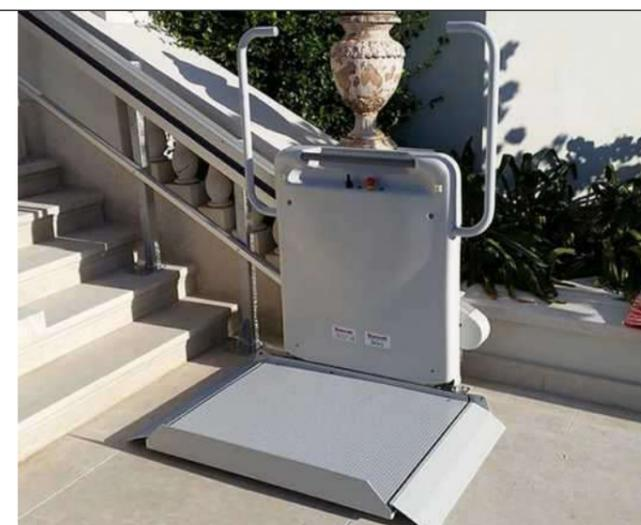
PUR GARANTENDO LA POSSIBILITÀ DI SUPERARE DISLIVELLI ANCHE SIGNIFICATIVI, LO STRUMENTO DEL SERVOSCALA DOVRÀ ESSERE UTILIZZATO SOLAMENTE QUANDO IL DISLIVELLO NON PUÒ ESSERE SUPERATO CON LE ALTRE TIPOLOGIE DI SOLUZIONE PROGETTUALE IN QUANTO IL SUO UTILIZZO DA PARTE DELLA PERSONA SU SEDIA A RUOTE RISULTA SPESSO COMPLICATO E NON AUTONOMO.
