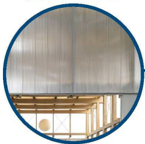
copertura in policarbonato
