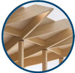
travi in legno lamellare
