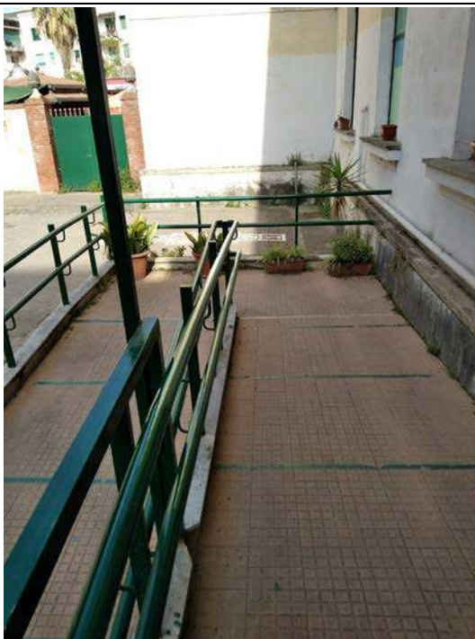
b.3.2 Presenza di rampe di accesso ai percorsi pedonali
