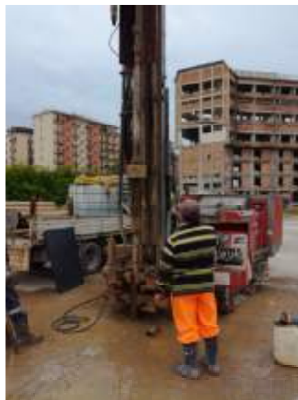
Foto 2 Esecuzione prova SPT nel foro di sondaggio S2
