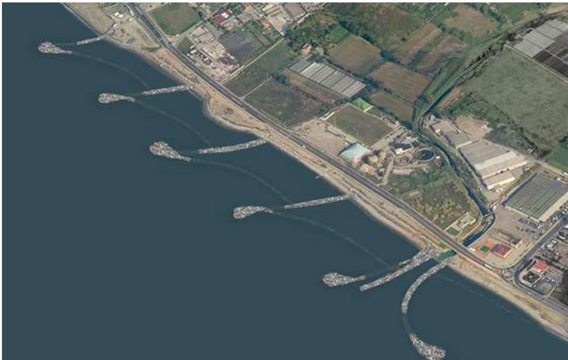
“Intervento di difesa, riqualificazione e valorizzazione della coste del Comune di Salerno” – ambito 4
